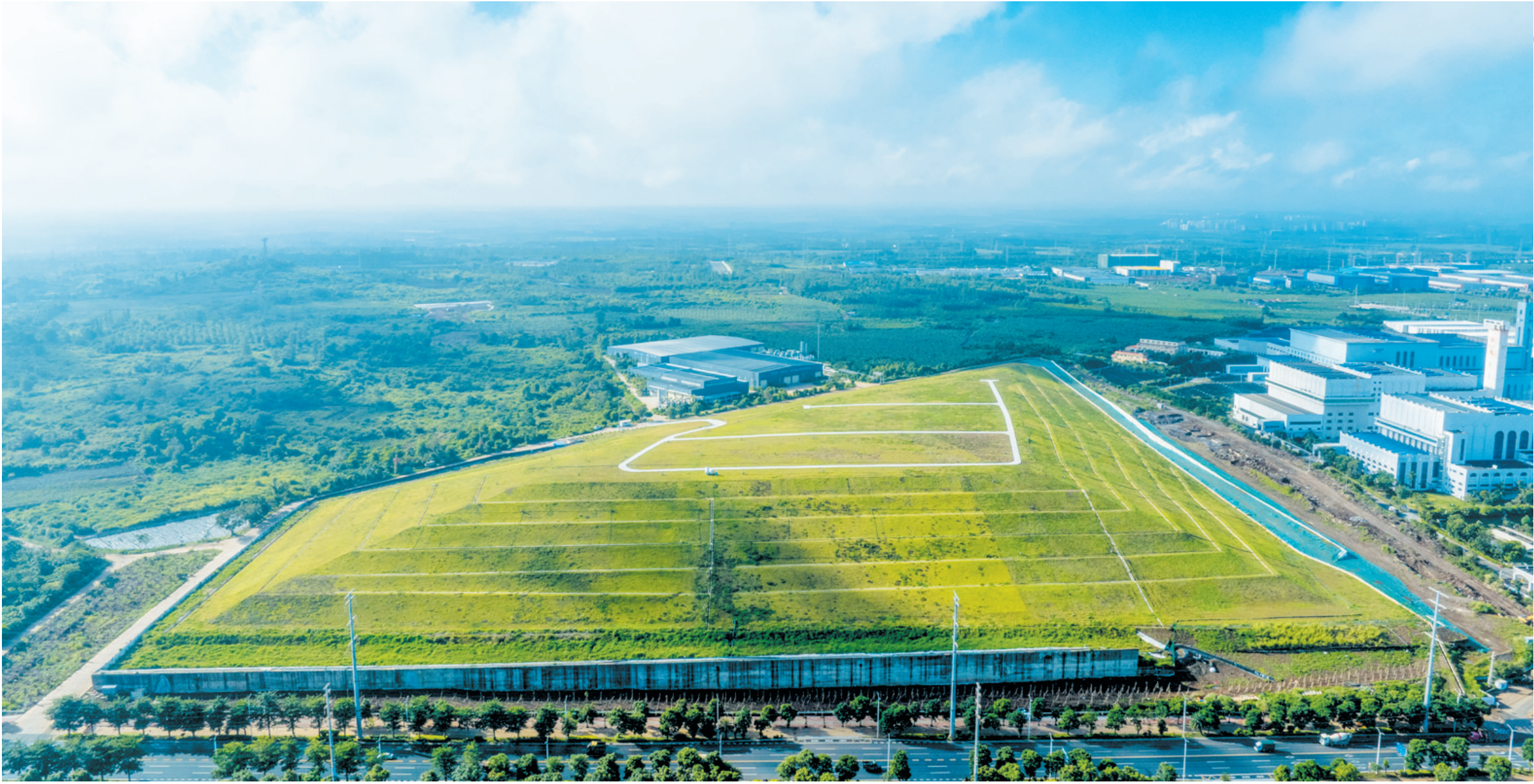
▲2026年10月18日,鸟瞰颜春岭生活垃圾填埋场环境治理和生态修复工程项目现场,绿地连片,生机盎然。本报记者 石中华 摄
