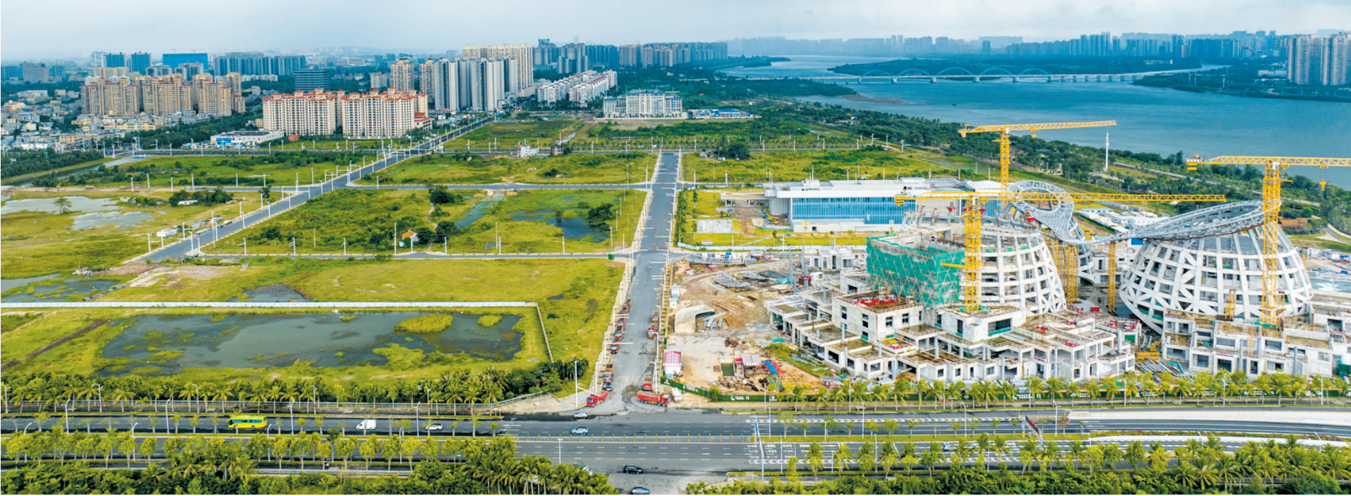
▲10月26日,俯瞰位于海口江东新区的海南省艺术中心和美术馆项目配套路网工程,路网骨架已基本成型。
